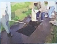
農道の部分補修
