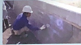
老朽化した水路壁のコーティング
